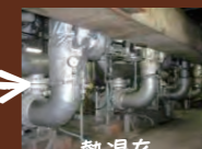
熱湯を 配管します
