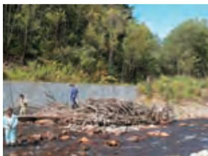
巨石と倒流木によるデブリキャッチャー（流木止め）。流木を捕捉するため、根系部を流れに向かって突き出させた。
