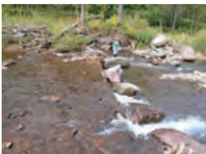
現地の巨石と倒流木をアンカーボルト、ワイヤーで固定した床固工
