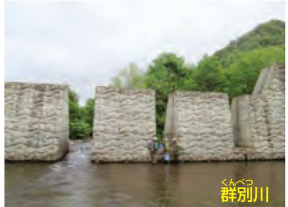
群別川下流のスリットダム。8箇所のスリットを持ち、うち2箇所は水面との落差がない（写真左側）。
