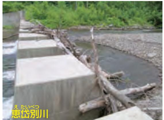
恵岱別川中流の砂防ダムのスリット。流木と土砂で閉塞し機能していない。
