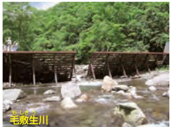
堆積土砂を放出させた鋼製ダムのスリット化
