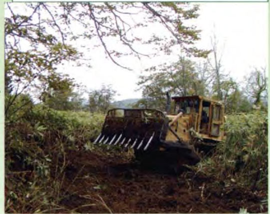
大型機械によるかき起こし
