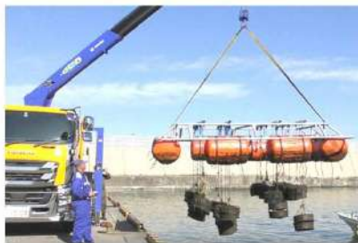
⑤ クレーンによる筏の陸揚げ
