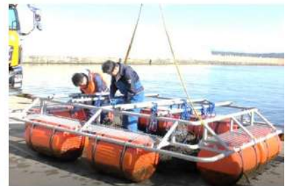
⑥ 養殖資材の取り外し
