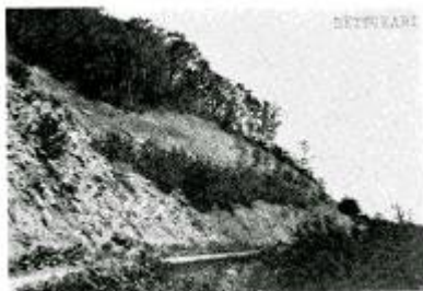
写真-40 国道 231 号線の切取り法面の犬走り上に侵入したケヤマハンノキ
