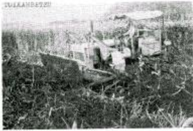
写真-38 ヨシ泥炭地におけるブルドーザーによる盛床地拵え (幌延町間寒別)
