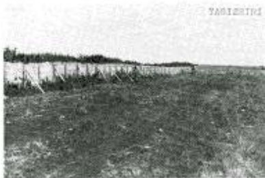
写真-17 ヤナギ類埋枝のための地はぎ、耕うん および床づくり (羽幌町焼尻)
