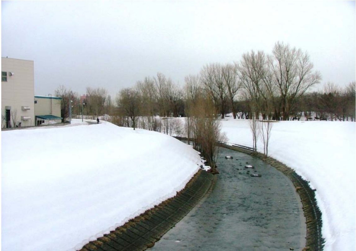
図2 寒月橋より下流を望む 右岸には農試公園があり、左岸は酒造工場と住宅地である
