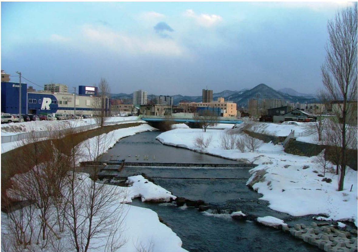
図3 あゆみ橋より上流を望む 上流には堰堤と魚道があり、右岸はパチンコ屋等の商業施設が立ち並ぶ。左岸は住宅地。
