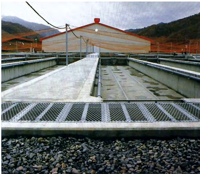
飼育池 より良い飼育環境を保ち健苗を養成するため、池底注水管、側壁散水管等を備えた合理的な構造にした。
