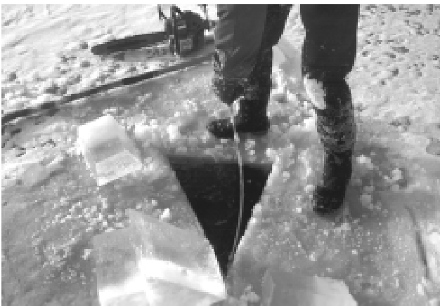
写真5 鉄製の鉤で板の先端部を探索・誘導する
