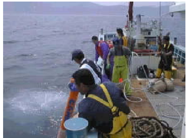
(写真2) 赤岩沖水深約40m地点でのブイ設置作業風景。アンカー用土嚢を投入した直後。持っているのは通信ユニット部先端。
