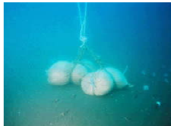
(写真6) 海底のアンカー用土嚢。重さは約300kg。
