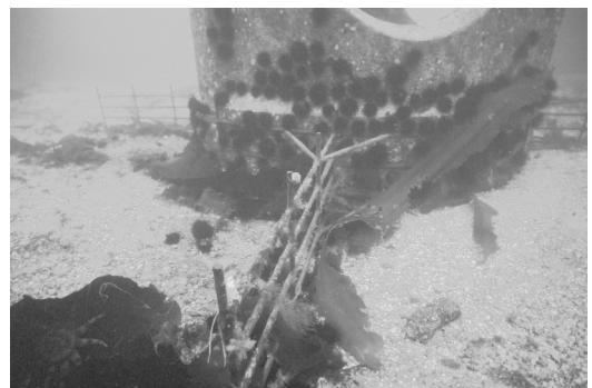
写真2 海藻を捕捉するためのブロックの鉄枠に引っかかったコンブ類
