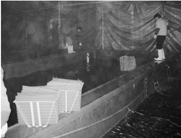
写真9 水槽掃除作業風景
