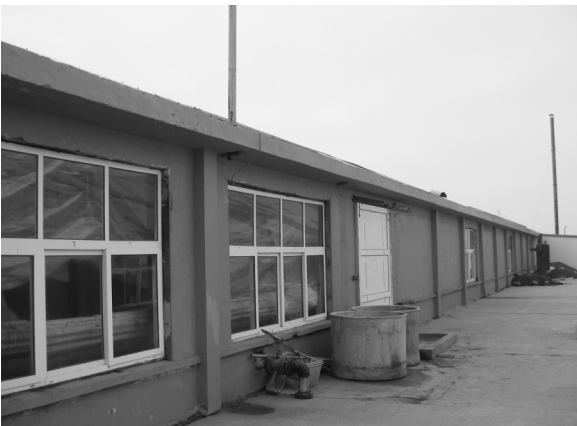
写真5 好当家（株）の種苗生産棟
