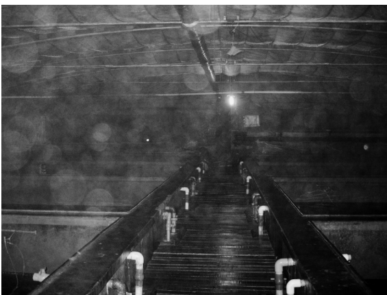
写真6 生産棟内部 棟内には20t水槽が20基並ぶ
