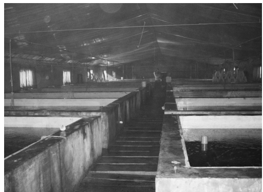
写真2 種苗生産施設内の様子 この棟の中には16tのコンクリート水槽が16基
