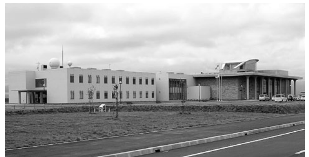
函館市国際水産・海洋総合研究センター全景
