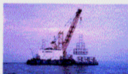
写真1 道央日本海島牧沖における試験構造物設置作業（平成5年8月）
