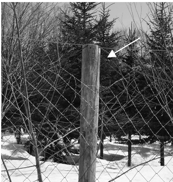
写真-2 設置後3冬経過した吊りロープ固定部の破網が横方向に広がった様子 (石狩厚田試験地)
