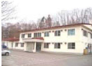
現在の本場庁舎全景 (建設当時と殆ど変わっていません)
