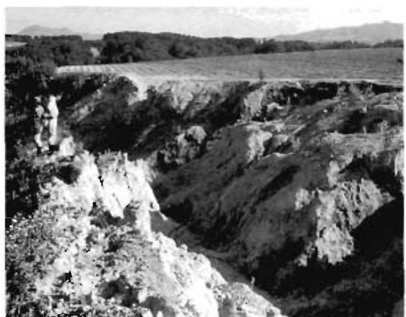
写真-2 ガリー侵食状崩壊タイプ
