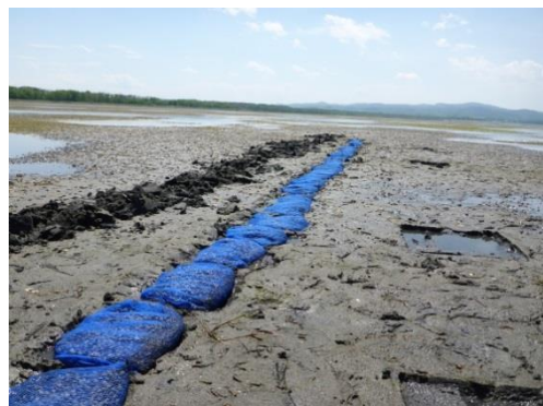
写真2 網袋の敷設状況
