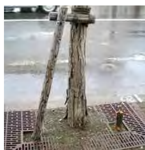
支柱の損傷
