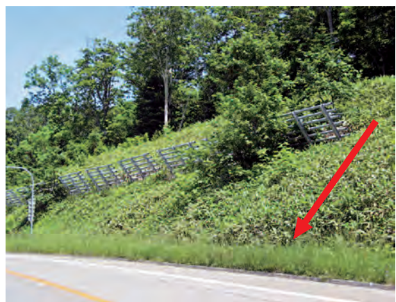
写真-4 盛土のり面を上るササ(左)と切土のり面を下るササ(右) 注: ←は、地下茎の伸長方向を示す
