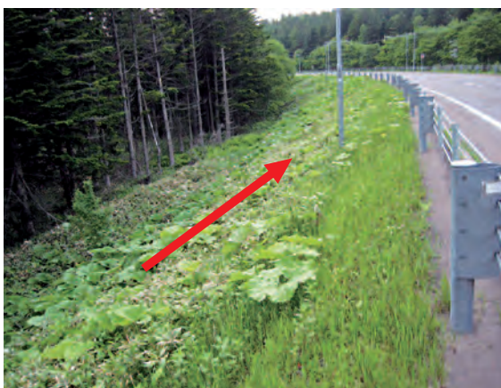
写真-4 盛土のり面を上るササ(左)と切土のり面を下るササ(右) 注: ←は、地下茎の伸長方向を示す
