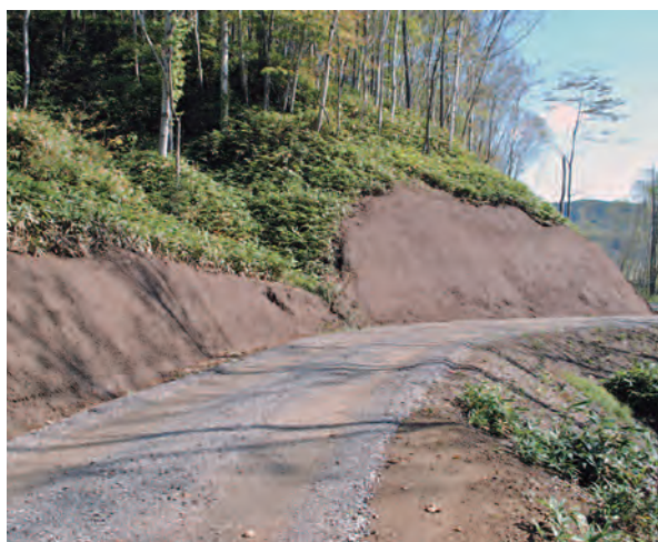
写真-2 造成中の切土のり面と、のり肩に接する自生のクマイザサ
