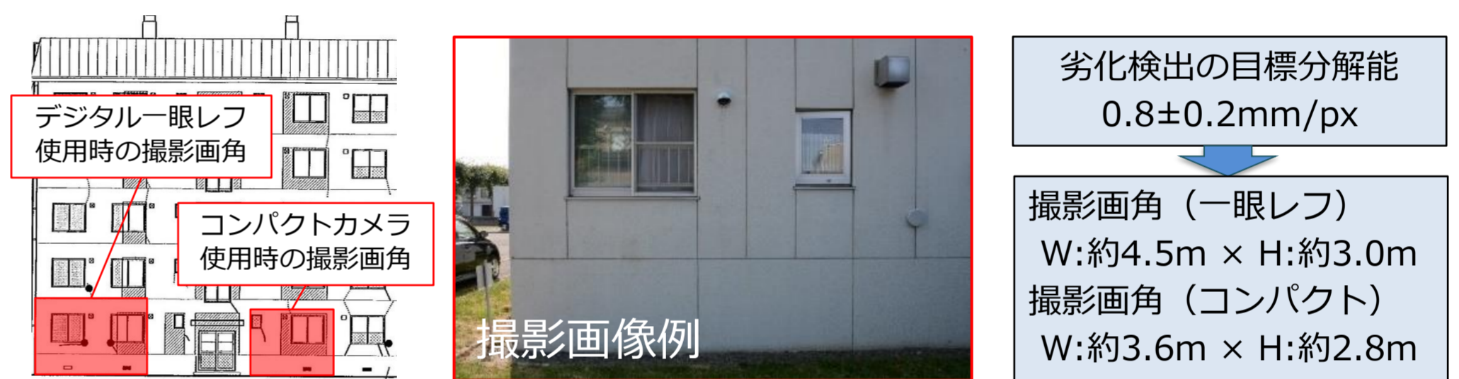
図3 画像分解能を満足する建物外壁の撮影方法
