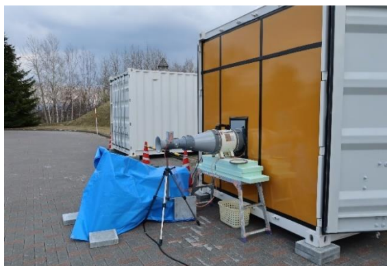
写真3 気密性能測定状況
