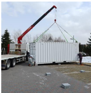
(a)コンテナ設置状況
