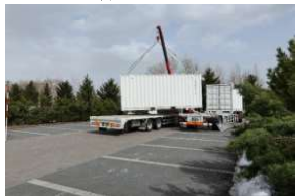
(d) トレーラーからのコンテナの積み替え
