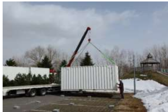
(b) コンテナ設置
