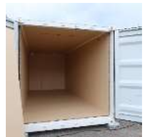
(c)通気資材張り(入口側のケンドン式パネルを取り外した状況)
