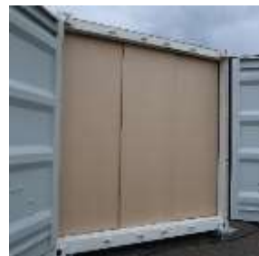
(b) 通気資材張り
