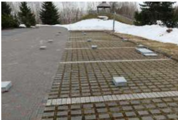
(a) 平板ブロック設置状況
