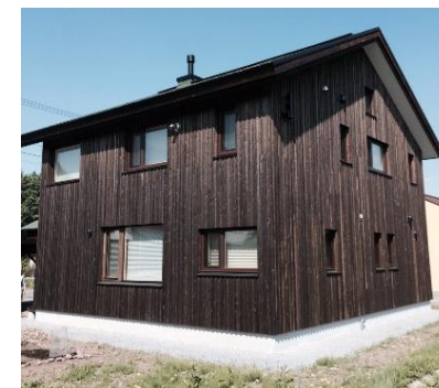
木材を外装材に用いた住宅
