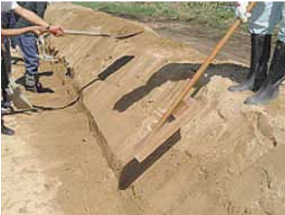
(土盛りの土固め)
