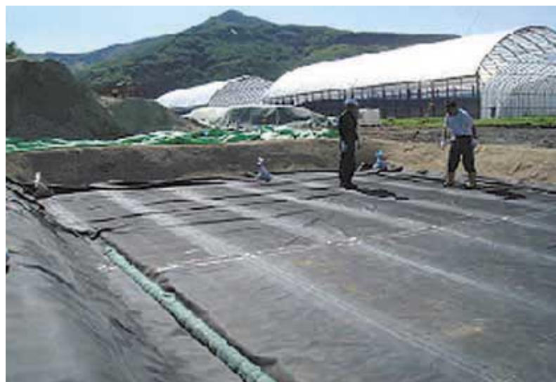
(集水管の設置)
