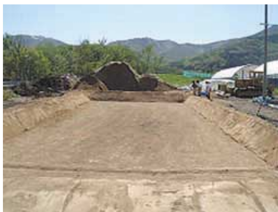
(作業機の搬入口は土盛りの高さを低くする)
