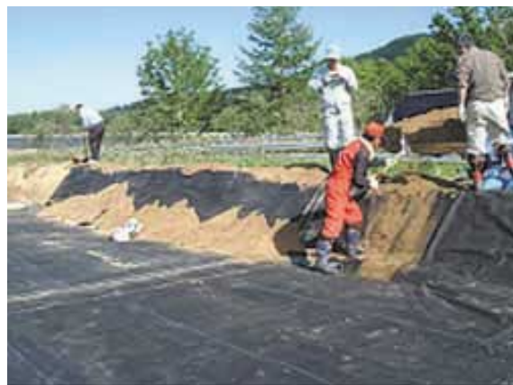
(床土によるシートの仮固定作業)
