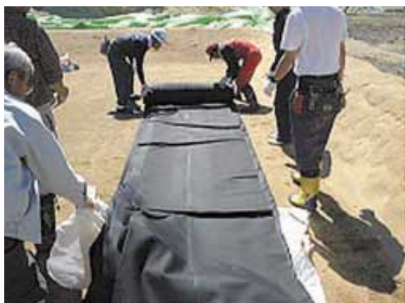
(シートの設置作業)
