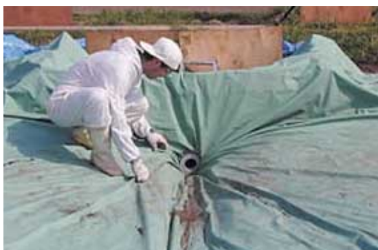
根釧農業試験場の例 シートとパイプの密閉接続(ポリフィッティング)を利用
