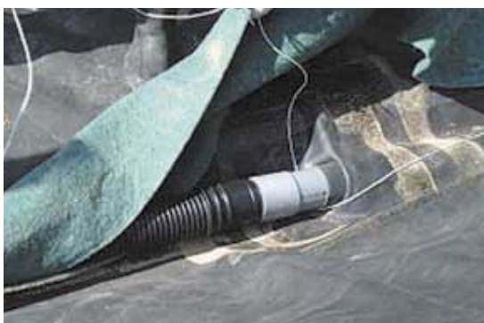
畜産試験場の例 集水管とぴったりはまるサイズのゴム製の接合部を利用
