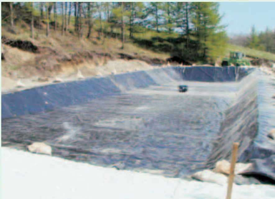
底部シートの設置完了
