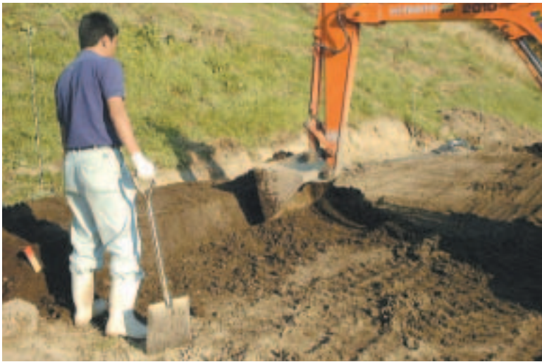
盛土の成形作業
