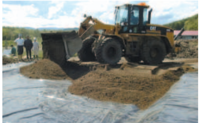
土の搬入作業
