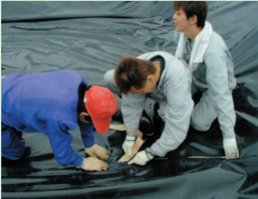
底部シートのプロチレンテープによる設置作業
