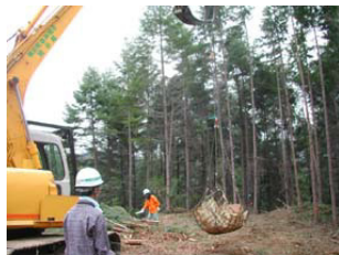
ロードセル・もっこを用いた重量計測
