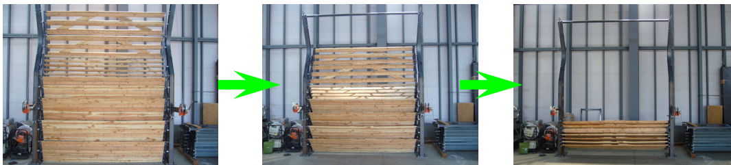
写真-2 折畳み式木製防雪柵
