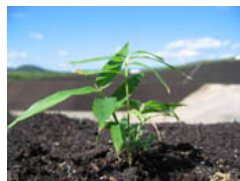
写真-2 道路法面への組織培養苗(クマイザサ)の植栽(於:道道枝幸音威子府線)
