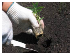
写真-2 道路法面への組織培養苗(クマイザサ)の植栽(於:道道枝幸音威子府線)
