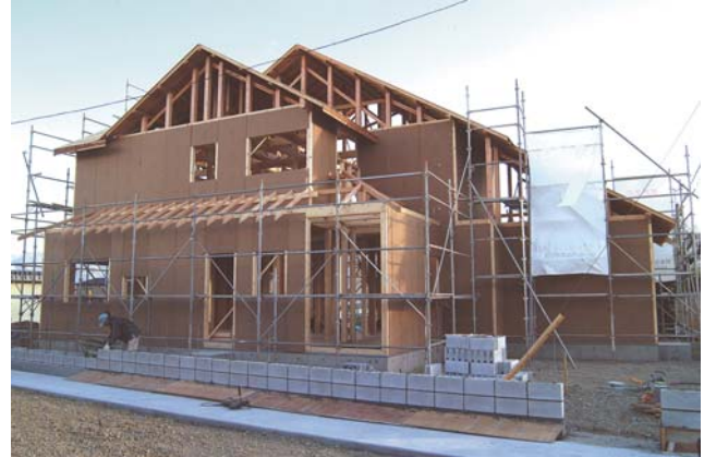
写真1 耐力壁に用いられた構造用MDF
