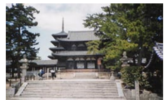
写真 2 現存する世界最古の木造建築（法隆寺）※1400年にわたるメンテナンスのたまもの
