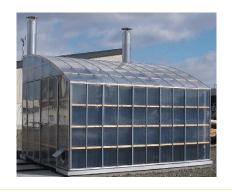
開発したものです。これはコンクリートの床に鋼材で骨組みを造り、その骨組みを挟むように三重構造のビニールフィルムを張っています。また、乾燥室の内側には炭素繊維のシートを全面に張り、太陽熱を集める効率を高めています。大きさは間口 4.5m、奥行き5m、高さ 3.8m で、室内空気を循環させるためのファンを備えています。室内空気を排気するための円筒は断熱構造になっていて、これにより電動ファンを使うことなく乾燥室内の空気を排出することができます。
