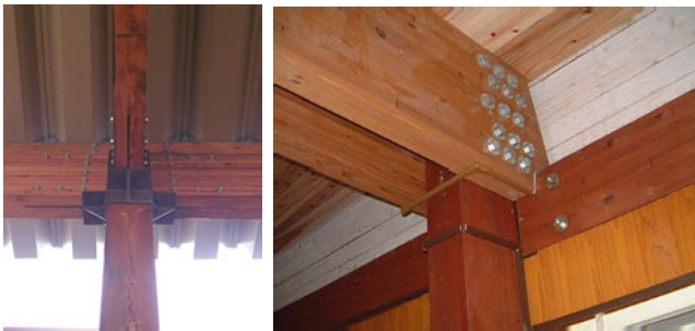
写真2 鋼板挿入接合・合わせ梁の例
