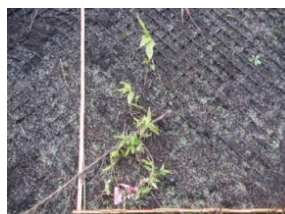
写真6 基盤材が流亡して基盤厚が1cm程度になった箇所(左)と基盤材の厚さが3cm程度の箇所(右)
