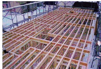
写真3 住宅での試験施工
