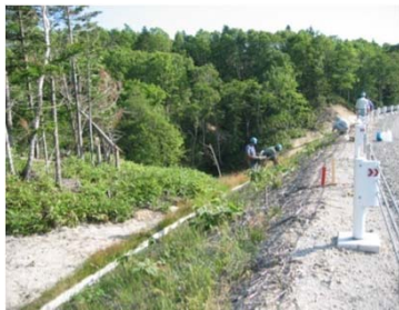
南東向きのり面
