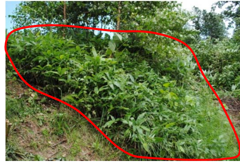
南東向きのり面
