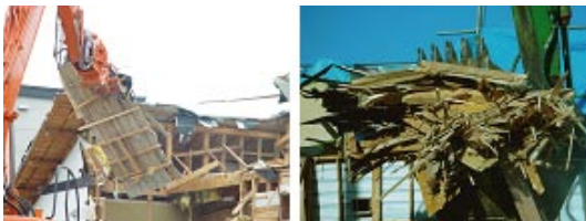
木造住宅の解体
