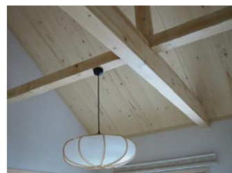
写真1 内装用針葉樹合板の施工例
