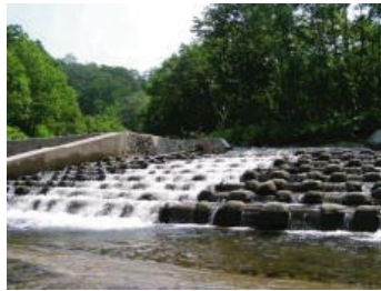
自然環境を守る取組 治山ダムへの魚道の設置 (斜里町)
