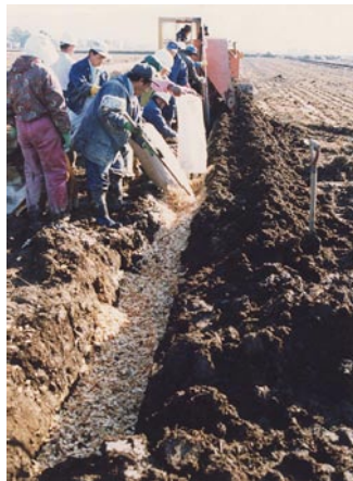
写真1 耕作地における木材チップ疎水材の施工状況
