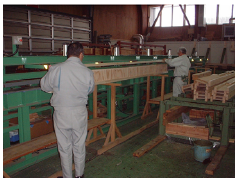
道産I形梁の製造試験
