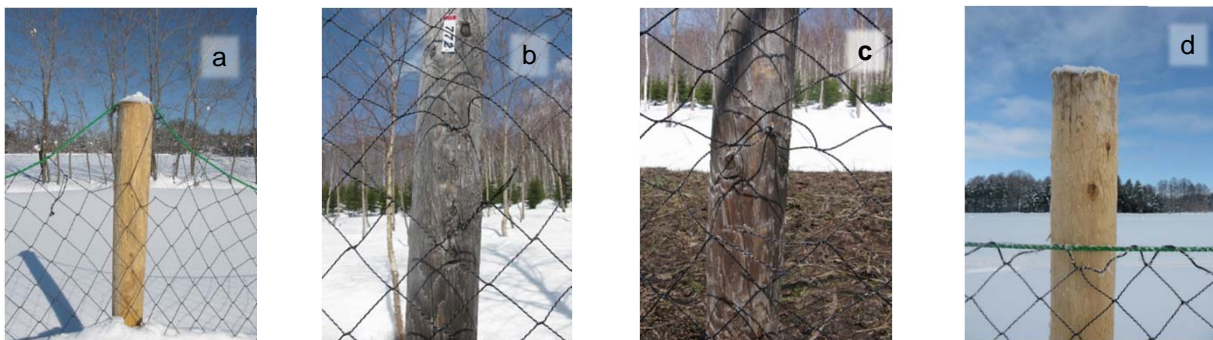
写真-1 確認されたネットの損傷の種類
