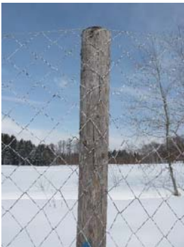
写真1 ワイヤーロープと新開発ネットを用いた柵の設置状況
