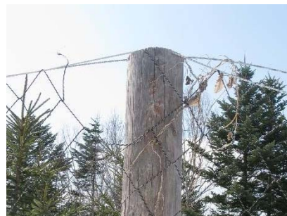
写真3 ワイヤーロープが弛んだことで切断した網糸
