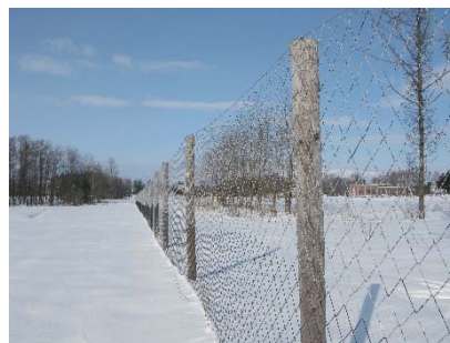
写真1 ワイヤロープと新開発ネットを用いた柵の設置状況
