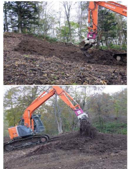
図1 表土除去区（上）と表土埋戻し区（下）の施工状況
