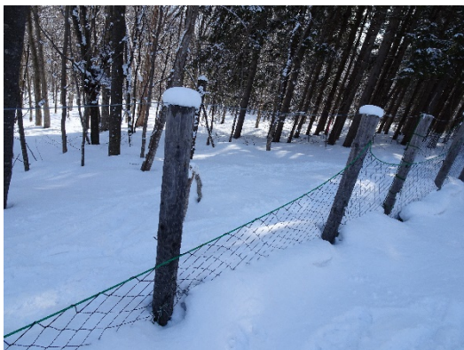
写真-1 支柱側面に固定して吊りロープが落下した状態。
