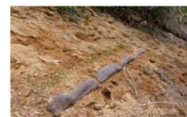
写真-1 表土安定工の施工状況
