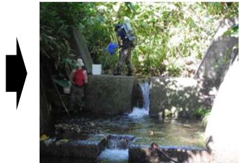
写真-2 複断面化された治山ダムの例
