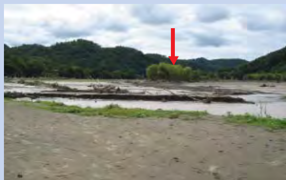
写真 - 1 河畔林の被害形態区分 空中写真による消失林（赤）、倒伏林（青）、残存林（緑）の区分（上）と被害後の現地写真（下）。矢印の残存林が正しく判読されていることが分かる。
