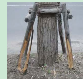
④ 支柱の損傷
