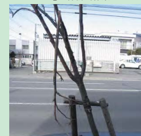
③ 枝が折れ傾いた小径木・支柱
