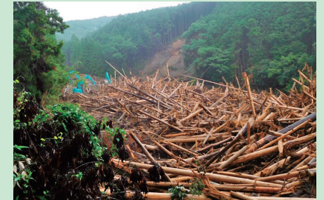
写真-2 ダムが捕捉した大量の流木
