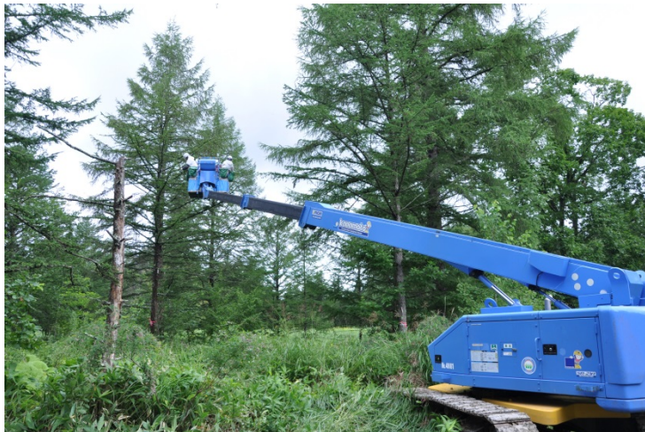
写真9 クローラー式高所作業車
